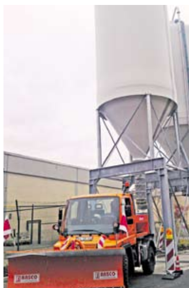
Salz-Silos machen das Beladen einfacher
