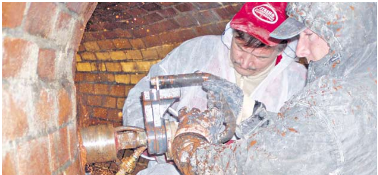
Aufschlussreich: Bohrkernentnahme in den gemauerten Kanälen
